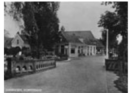
Kieftenbrug 1937: De brug met bijzondere bakstenen muurtjes, die in de 2e WK werden vernield.
